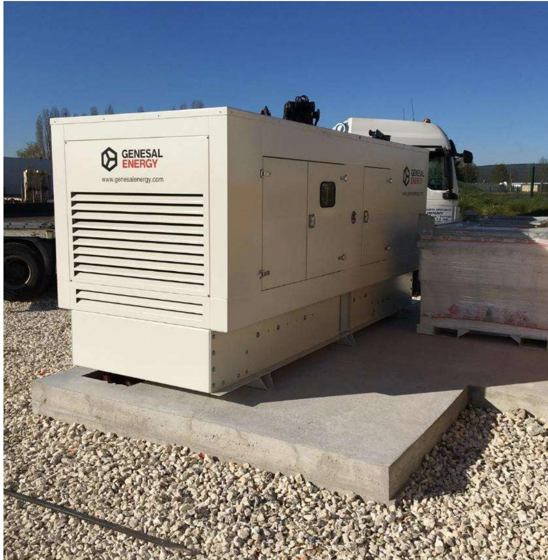
Mise en place d'un groupe électrogène de 400 Kva qui, en cas de coupure du réseau électrique, a pour objectif de :
